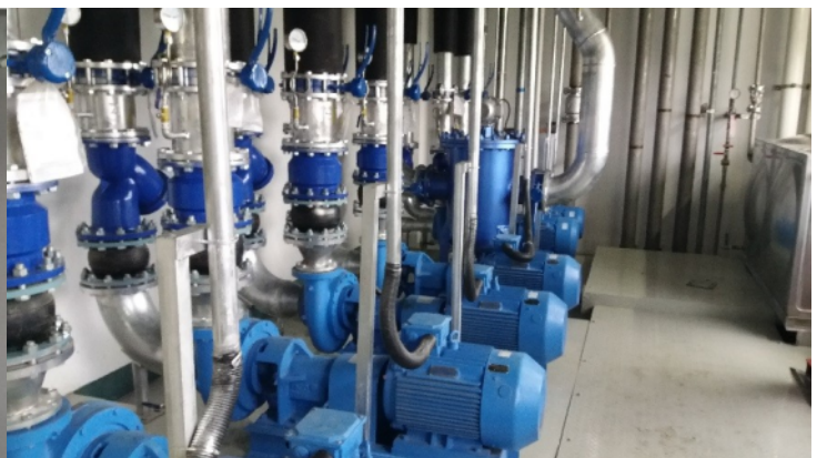
图2. 海利普三期厂房中央空调系统电机组
