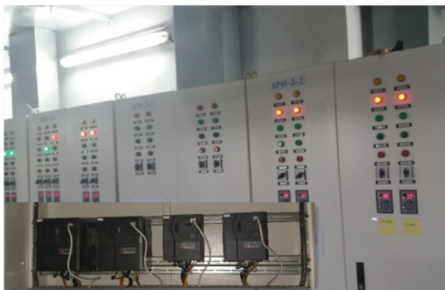
图1. 海利普三期厂房中央空调系统电气柜及柜中变频器
